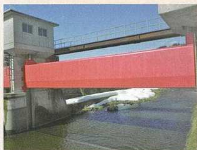
洪水吐ゲート (完成)
